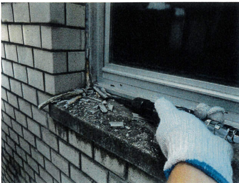
シーリング工事
