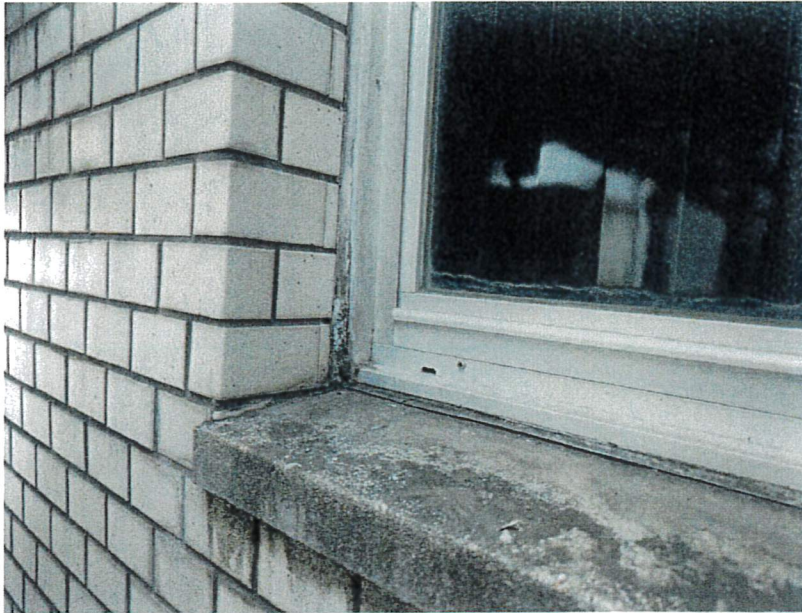
シーリング工事
