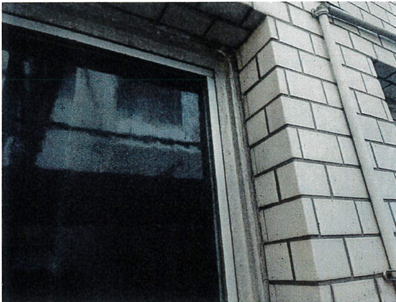
シーリング工事
